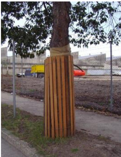
Rysunek 4 Przykład prawidłowego odeskowania drzewa podczas prac budowlanych
